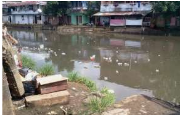
Gambar 3. Kondisi Fisik Kuala Jengki
