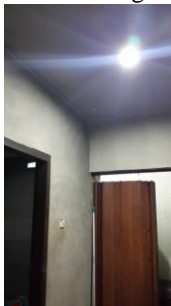
Gambar.9. Tampak Toilet dan akses belakang dapur (Dokumentasi Pribadi)
