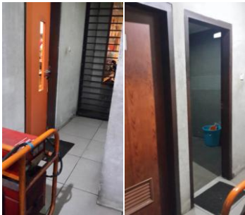
Gambar.8. Area Loading Dock dan Toilet Pengunjung (Dokumentasi Pribadi)
