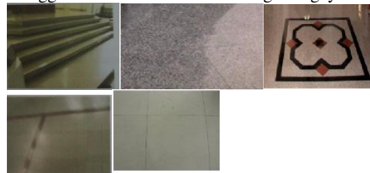
Gambar 6. Lantai Granit pada Sampel Analisa Data
