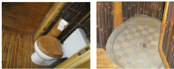
Gambar 16 (a) Lantai Bambu Kamar Mandi, dan (b) Lantai Area Shower
