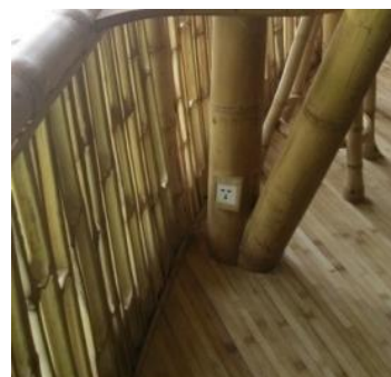
Gambar 4 Railing Pada Area Tengah
