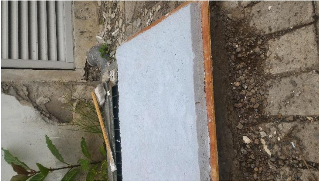
Gambar 4.2.10. Cetakan Kertas dilepas dari Cetakan Balok.
