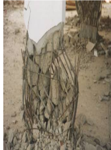
Foto 20. Sambungan antara besi longitudinal
