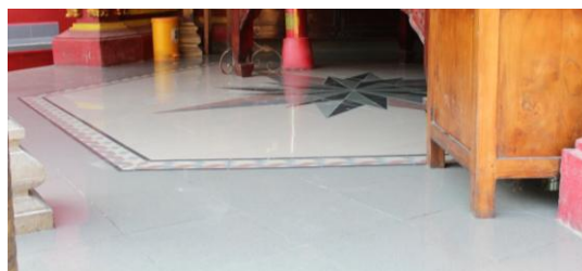
Sumber: Dokumentasi Pribadi. Gambar 13. Lantai Gedung Taois.
