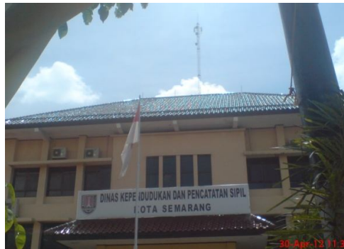
Gambar 4.4. Tower pemancar Dinas Kependudukan dan Pencatatan Sipil
