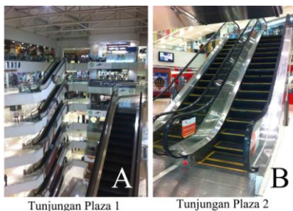
Gambar 13. Eskalator di “Tunjungan Plaza” 1 (A) dan 2 (B) dengan konfigurasi paired dan stacked escalator
