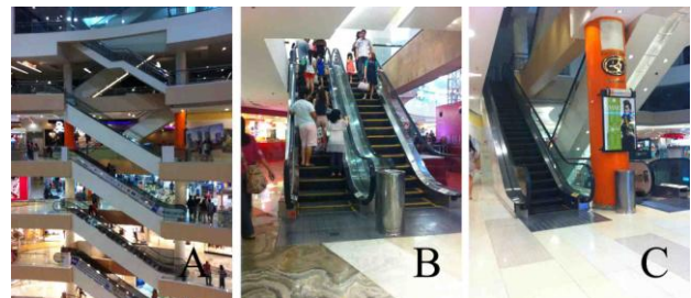
Gambar 15. Eskalator di “Tunjungan Plaza” 3 area A dengan konfigurasi pair escalator (A), paired paralel escalator (B) dan crossed escalator (C)
