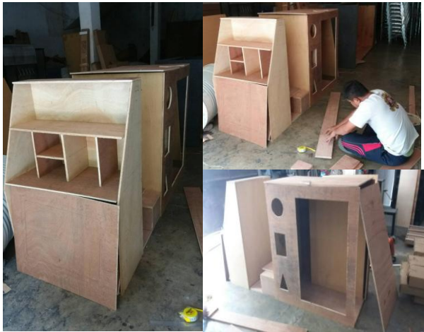
Gambar 13. Proses pembuatan kerangka (Sumber : dokumentasi pribadi, 2017)
