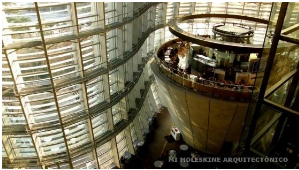
Gambar. 40. Area Café National Art Center yang terletak di atas bentukan kerucut terbalik dan terbuat dari beton.
