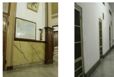
Gambar 32. (a) Dinding pada lorong depan (b) Dinding pada lorong belakang
