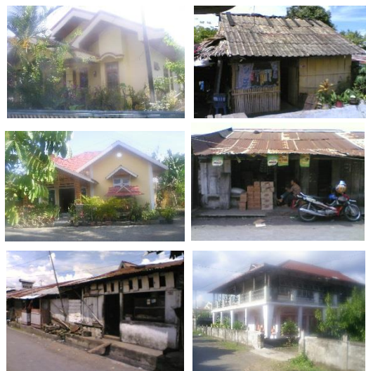
Gambar 2. Kondisi Bangunan dan lingkungan
