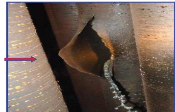
Gambar 1. Segmen pipa pecah pada baris 2 nomor 4.
