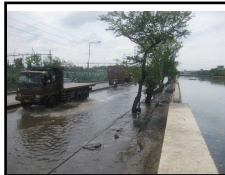
Gambar 2 menunjukkan jalan yang tergenang banjir pasang laut
