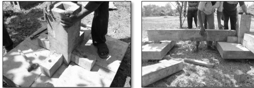
Gambar 6. Pemasangan Sistem Interlocking Sistem 4
