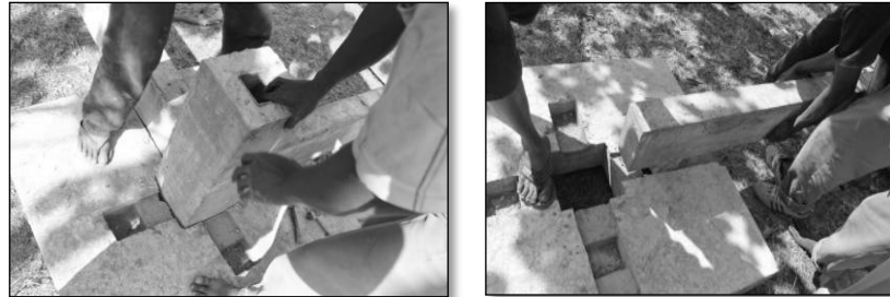
Gambar 5. Pemasangan Interlocking Sistem 3
