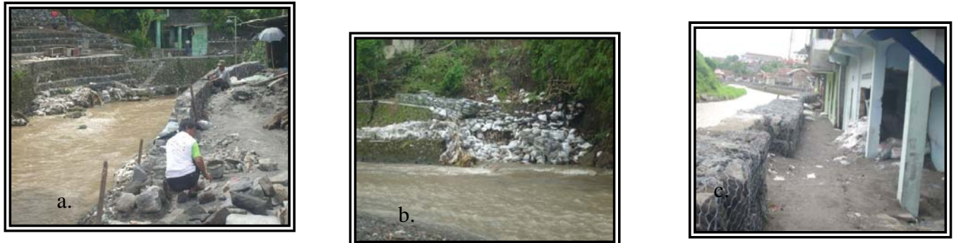
Gambar 3. a. Kerusakan Tanggul (Kelurahan Cokrodiningratan dan Kelurahan Jetis), b. longsor Tebing (Kelurahan Cokrodiningratan dan Kelurahan Jetis), c. Sedimentasi Material (Kelurahan Gowongan) (Dokumentasi Tahun 2011)
