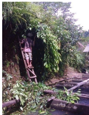
Gambar 4.2 Perbaikan dan pembersihan kolam yang rusak
