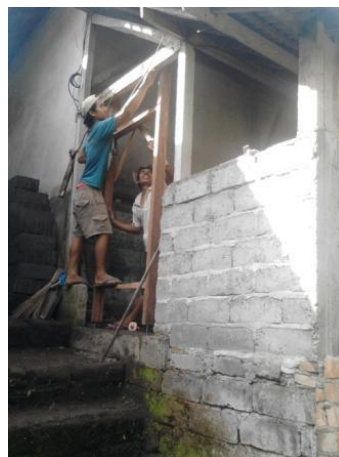
Gambar 4.7 Pemasangan pintu kayu
