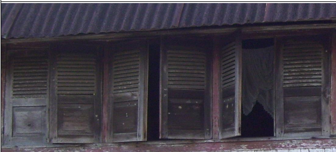
Gambar 3. Gambar Jendela Rumah Di Taratak Buluh
