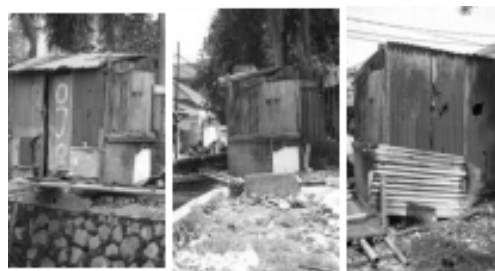
Gambar 3. Kondisi dinding permukiman kumuh
