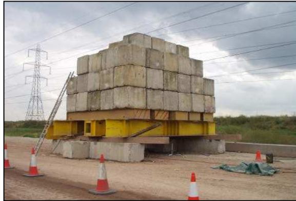
Gambar.1. Tes Uji Beban (Sumber : Handbook Pile Testing, 2006)
