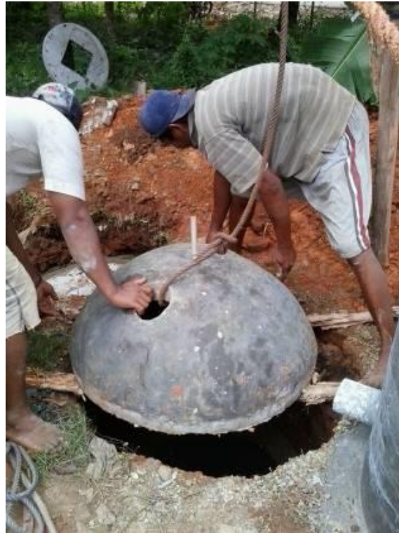
Gambar 2. Pemasangan tutup digester
