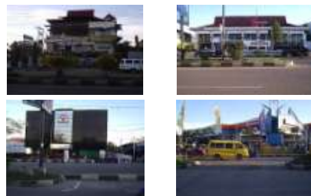
Gambar 4. Bangunan yang memiliki entrance
