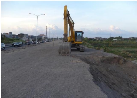
Gambar 64. Pekerjaan pembongkaran preload
