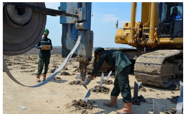
Gambar 26. Pemasangan sepatu pelat
