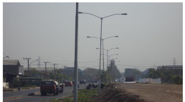
Gambar 9. Kerusakan tiang lampu jalan
