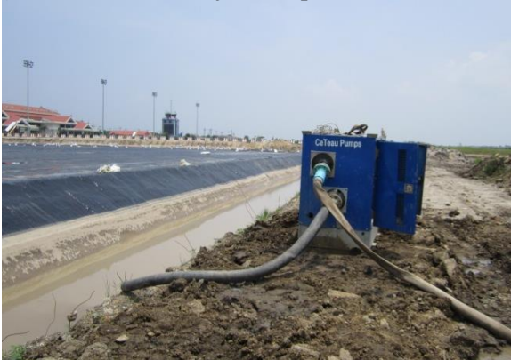
Gambar 68. Pekerjaan pompa vacuum
