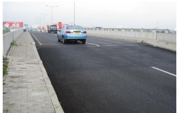
Gambar 7. Kerusakan oprit jembatan
