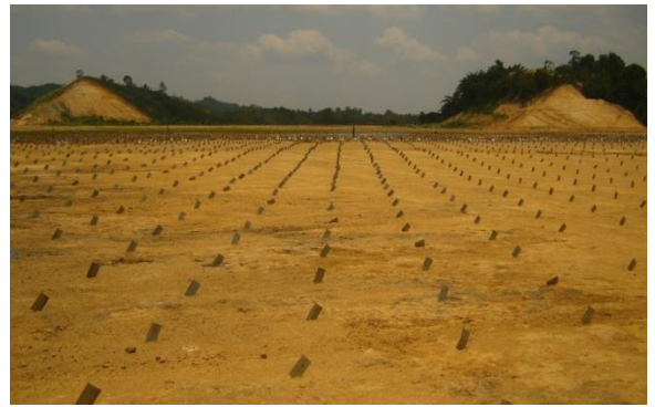
Gambar 25. Pola pemasangan PVD di lapangan
