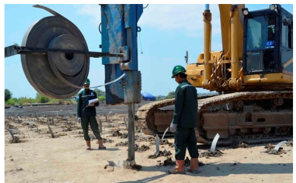
Gambar 27. Pemancangan mandrel ke tanah
