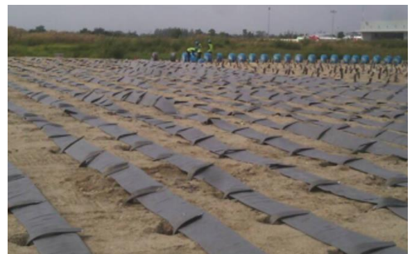
Gambar 38. PHD metoda vacuum consolidation Pada Gambar 37 ditunjukkan penggunaan PHD sebagai horizontal drain pada pekerjaan perbaikan tanah tanah lempung lunak metoda preloading dengan PVD. PHD yang digunakan ukuran 20mm x 100mm. Pada Gambar 38 ditunjukkan penggunaan PHD sebagai horizontal drain pada pekerjaan perbaikan tanah tanah lempung lunak metoda vacuum consolidation . PHD yang digunakan ukuran 20mm x 300mm.
