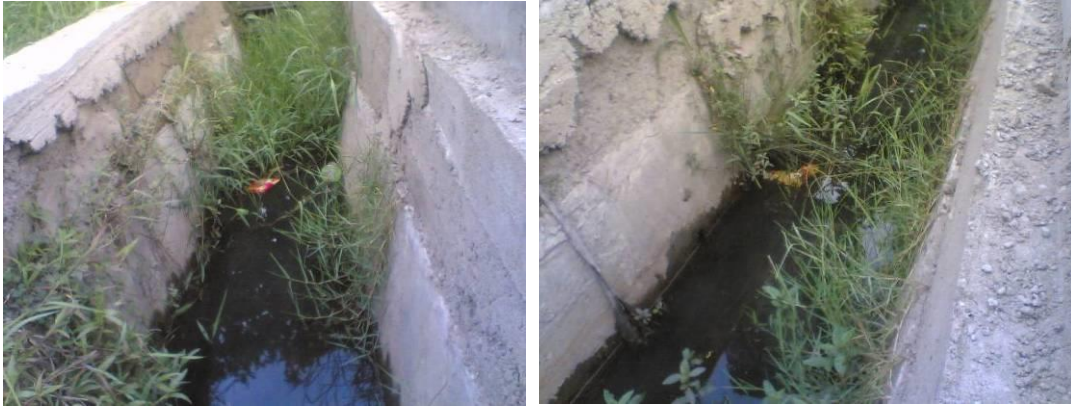
Gambar 5. Saluran drainase di Jalan GatotSubroto
