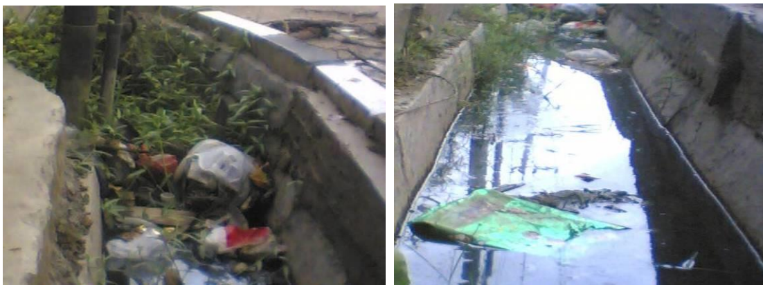
Gambar 6. Saluran drainase di Jalan GatotSubroto
