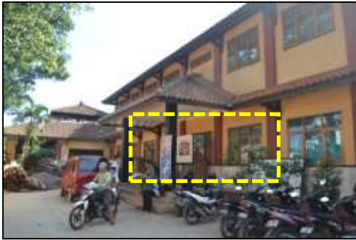
Gambar 4. Bukaan jendela sisi utara
