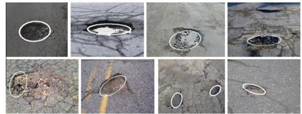
**Gambar 1.** Hasil Pendeteksian Lubang
