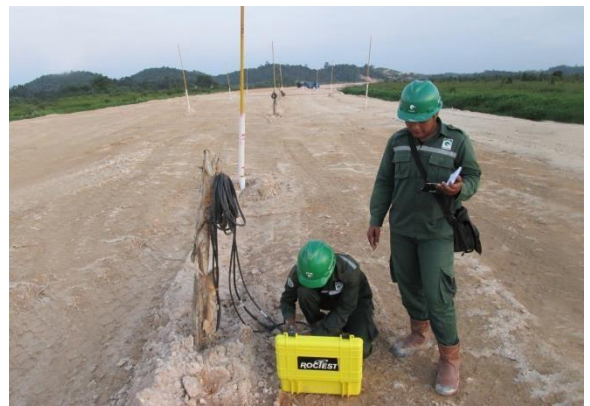
Gambar 95. Monitoring instrumen geoteknik
