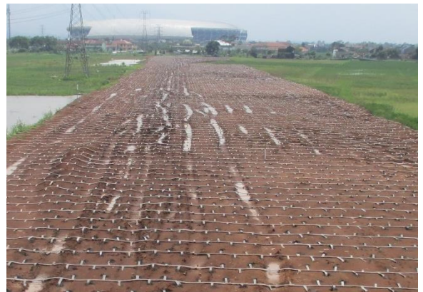
Gambar 48. Pemasangan PHD pada 2 PVD
