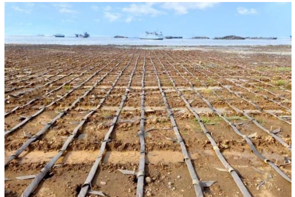
Gambar 47. Pemasangan PHD pada 1 PVD
