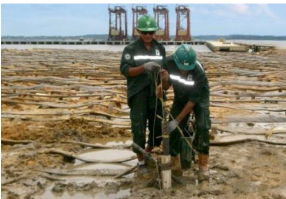
Gambar 53. Pemasangan vibrating wire pm.
