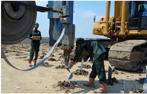
Gambar 44. Pemasangan sepatu pelat
