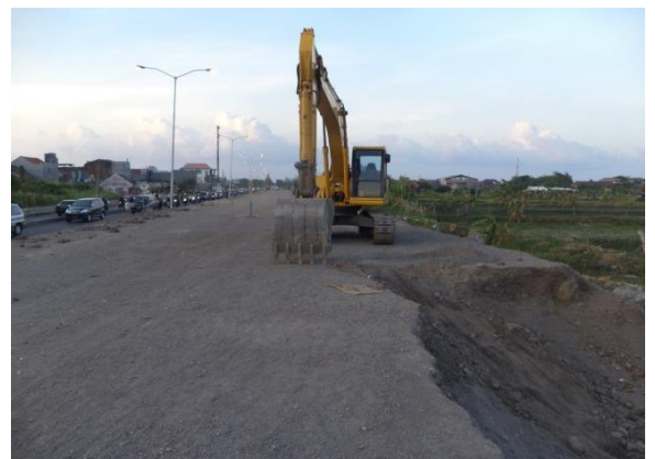
Gambar 74. Pembongkaran timbunan preload
