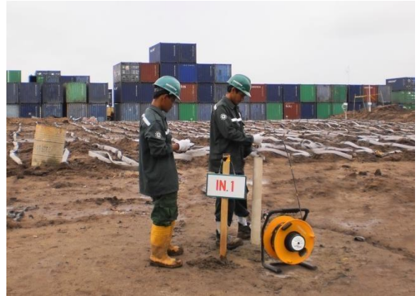
Gambar 80. Monitoring instrumen geoteknik
