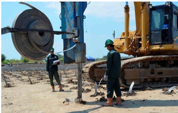
Gambar 45. Pemancangan mandrel ke tanah
