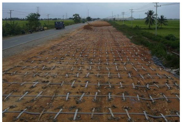
Gambar 49. Pemasangan PHD pada 2 PVD
