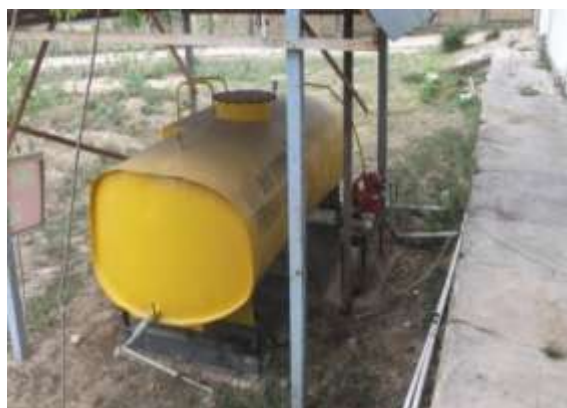
Gambar 7. Tangki penampung biogas
