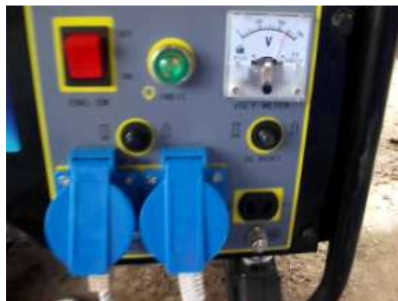
Gambar 16. Genset dengan beban dua buah setrika
