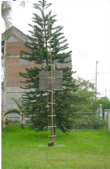
Gambar 7 Antena dengan Tuner dan kabel Coaxial.
