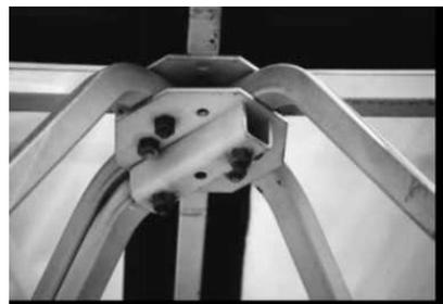
Penerapan Mai Sky system yang berbentuk geometri persegi atau kotak yang menjadi dasar pada bagian canopy. Yang di dalamnya terdapat material yang kompleks yang me bentuk rangkaian grid.
