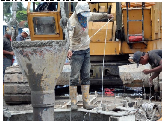
Gambar 6. Kontinuitas pengukuran kedalaman elevasi penuangan pasta beton
