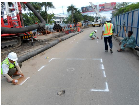
Gambar 1. Plotting posisi boredpile
