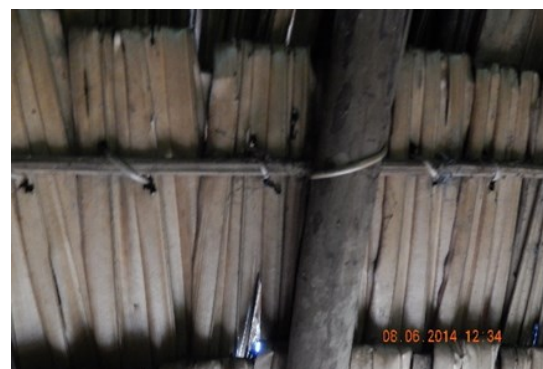
Gambar 3. Pandan gegas B. kurzii yang digunakan sebagai atap rumah/pondok Orang Rimba ( Pandan gegas (B. kurzii) used as the roof in the house of Orang Rimba )
