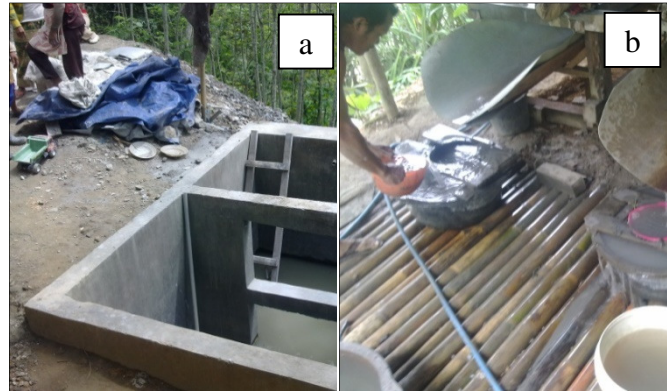
Gambar 3. Bak penampungan air dari proses penggilingan bijih. (a) bak pengendapan Hg dan (b) digunakan untuk menampung air dan material lempungan dari proses penggilingan terakhir
