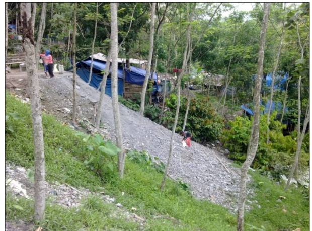
Gambar 6. Batuan sampling yang ditimbun dipinggir lereng, memungkinkan terjadinya longsor
