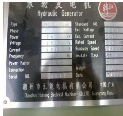
Gambar: 4 generator yang terpasang.
