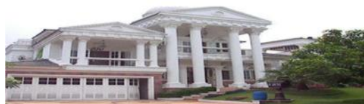
Gambar 15. Bangunan Bergaya Arsitektur Romantik
