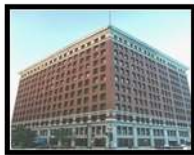
Penggunaan material baja sebagai struktur dan bata-bata sebagai dindingnya bisa meminimalkan keracok klob pada bangunan sehingga bisa menahan beban angin yang ada.
