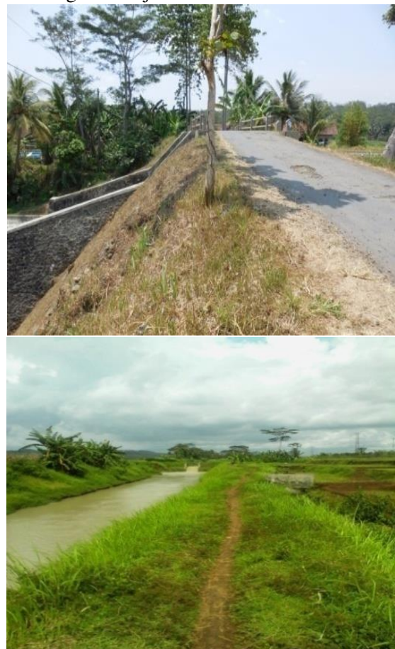
Gambar 3. (a) Bangunan Terjun B.BC 12a dan (b) Bangunan Terjun B.BC 13a
