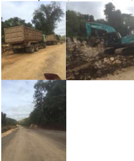
Gambar 2. Proses Pembangunan Jalur Lintas Selatan
