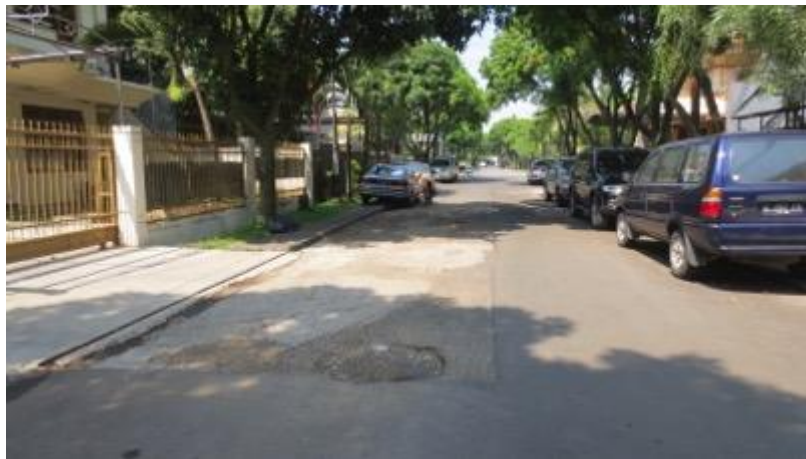
Gambar 1. Kondisi Jalan Perumahan Cluster E.
