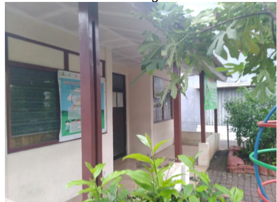
Gambar 1 : Kondisi Eksisting Depan Bangunan (Sumber : Survey, 2020)
