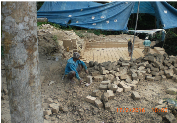
Gambar 4. Batuan Berupa Tuf yang Dimanfaatkan Penduduk sebagai Bahan “Batubata”
