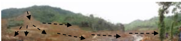
Gambar 15. Areal Terdampak dan Arah Gerakan Tanah Longsor ke Arah Sisi Utara (Vertikal ke Bawah) dan ke Arah Barat Laut dan Barat
