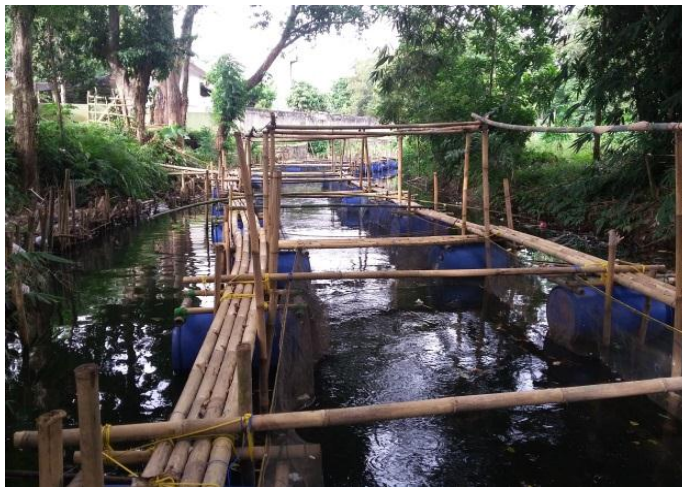
Gambar 4. Kolam Waring Apung
