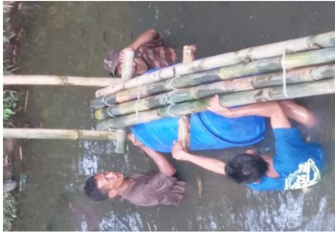
Gambar 3. Perakitan Kerangka Kolam
