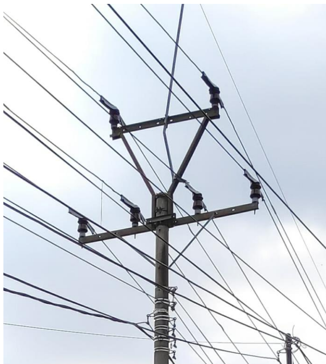
Gambar 7. Foto aktual Kontruksi Double Feeder 3B
