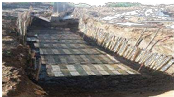
Gambar 2. Hasil Pemasangan Kistdam Dengan Turap Bambu dan Anyaman Bambu
