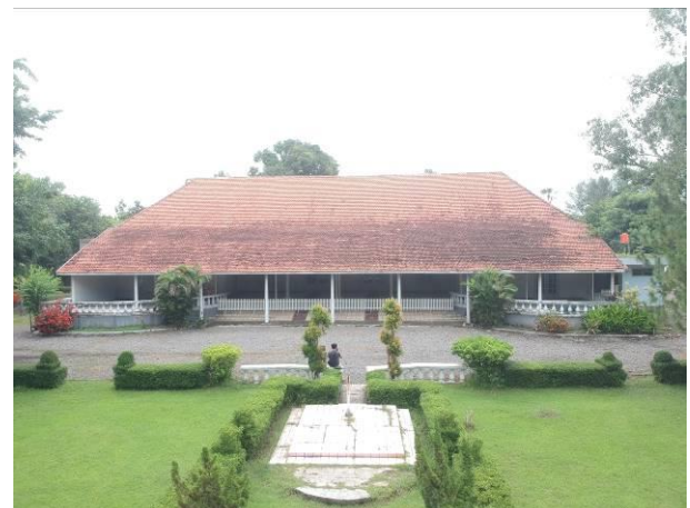
Gambar 3. Tampak Depan Rumah Mbesaran (Survey Lapangan, 2020)
