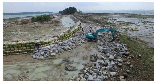
Gambar 1. Pemasangan buis beton sebagai seawall
