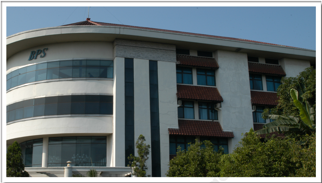
Gambar 7.3. Gedung Pusdiklat BPS, Jl. Raya Jagakarsa no. 70, Lenteng Agung
