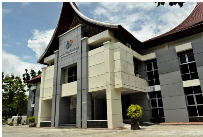
Revitalisasi gedung kantor BPS Provinsi Sumatera Barat kondisi sesudah dan sebelum revitalisasi
